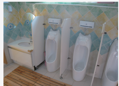
칸막이로 변기, 소변기를 분리한 4세~5세의 보육실 내 화장실
